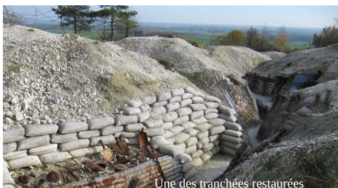
Une des tranchées restaurées
